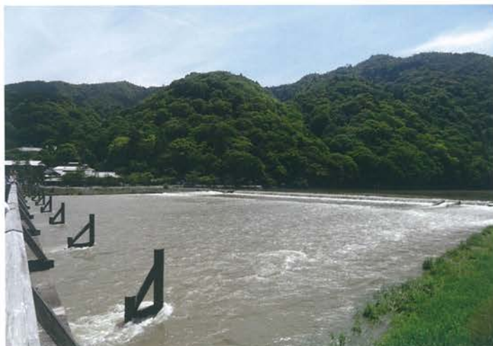
「葛野大堰」の現在の景観（嵐山渡月橋から一ノ井堰をのぞむ）
